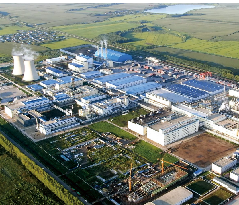
▲ 绥化象屿生化产业园区
